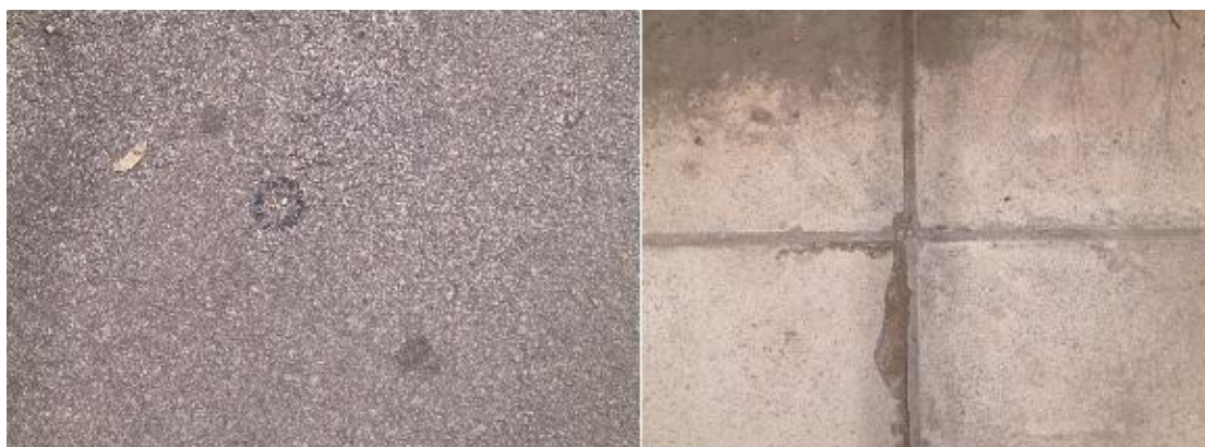
Εικόνα 8: Έκκεντρες στάσεις υλοποιημένες με καρφί
