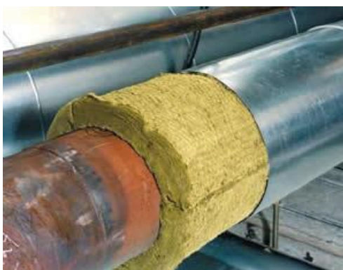
Εικόνα 2.13 Εφαρμογή πετροβάμβακα σε σωλήνωση
