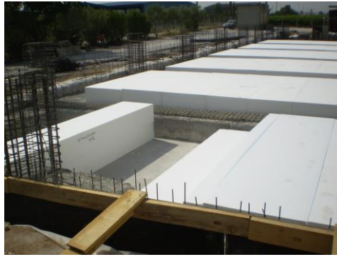
Εικόνα 2.5 Θερμομόνωση στοιχείων από σκυρόδεμα με διογκωμένη πολυστερίνη
