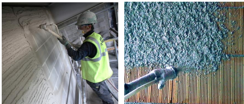
Εικόνα 2.6 Εφαρμογή θερμοσοβά με τη χρήση ψεκαστικού
