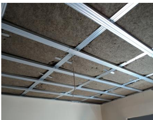
Εικόνα 2.12 Εφαρμογή στρώματος πετροβάμβακα σε οροφή
