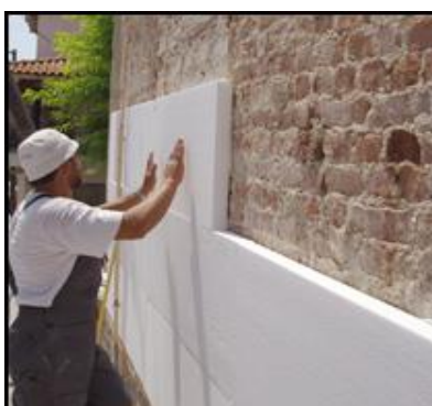
Εικόνα 2.4 Θερμομόνωση εξωτερικής τοιχοποιίας με διογκωμένη πολυστερίνη
