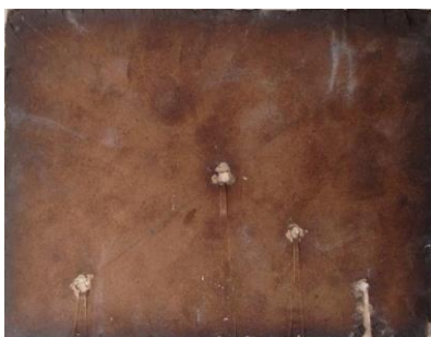
Εικόνα 4.15 Εξωτερική πλευρά δοκιμίου (Όψη Α)
