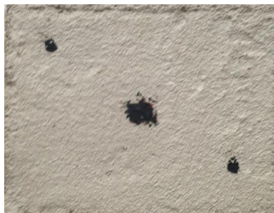
Εικόνα 3.45 Τοποθέτηση θερμοστοιχείων στην εξωτερική επιφάνεια του θερμοσοβά
