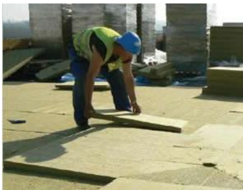
Εικόνα 2.11 Εφαρμογή στρώματος πετροβάμβακα σε στέγη
