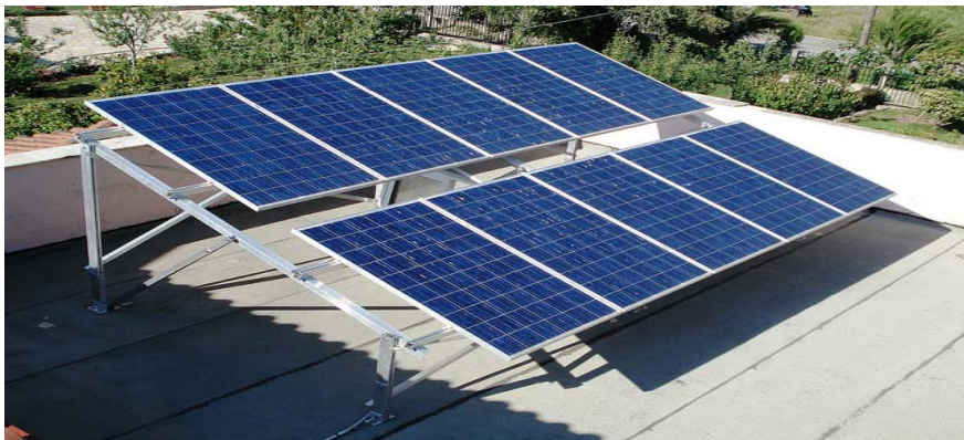
Εικόνα 3.7-4: Φωτοβολταϊκή συστοιχία που αποτελείται από 10 φ/β πλαίσια [ http://www.oleng.eu ].
