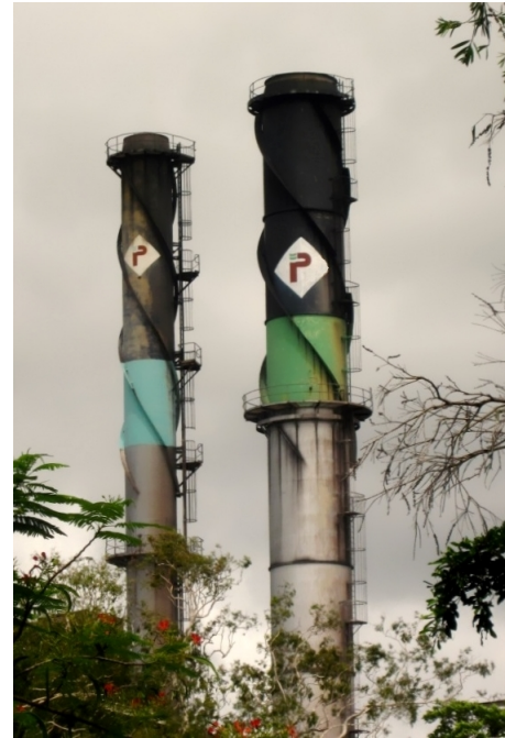
Σχήμα 1.5: Παθητικός έλεγχος των στροβίλων von Karman, με οριζόντιο και ελικοειδές πτερόγιο. [22]
