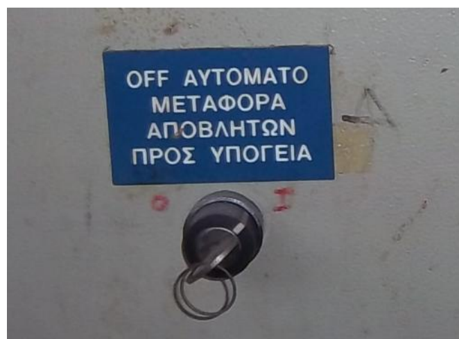
Εικόνα α.15: Παρέμβαση των χειριστών στην αντλία μεταφοράς αποβλήτων
