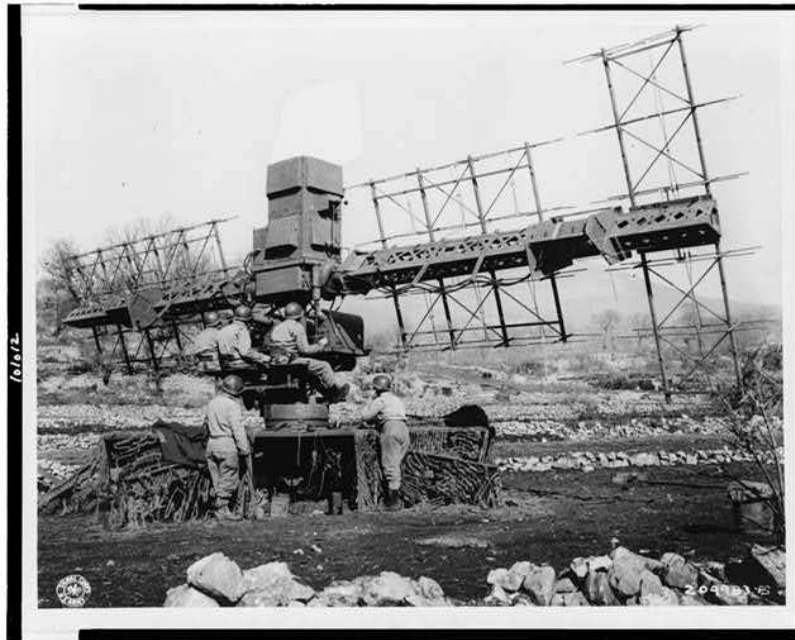
Εικόνα 1.1: Σύστημα RADAR κατά την διάρκεια του 2 ου Παγκοσμίου Πολέμου [ http://www.loc.gov/rr/scitech/trs/trsosrd.html ]
