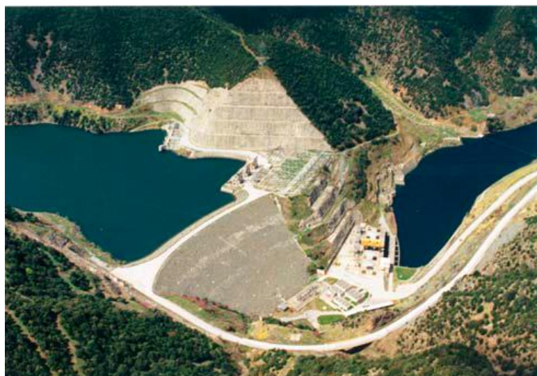
Εικόνα 4-9: Φράγμα ΥΗΕ Σφηκιάς.
