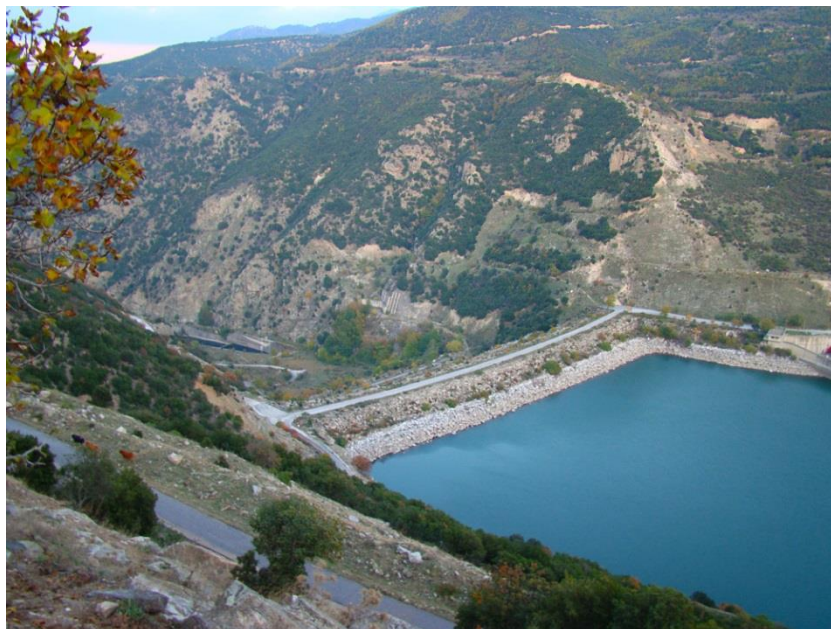
Εικόνα 4-8: Φράγμα ΥΗΕ Πολυφύτου.
