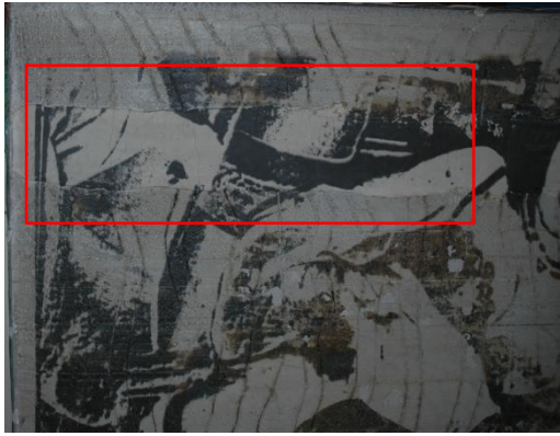
Σχ. 8.2.12. Πιθανός σπλισμός σε απόσταση κάμερας, d_{cam} = 24\text{cm}
