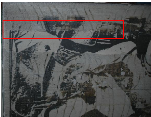
Σχ. 8.2.17. Διεπιφάνεια σοβά και κύριας επιφάνειας σε απόσταση κάμερας, d_{cam} = 154cm
