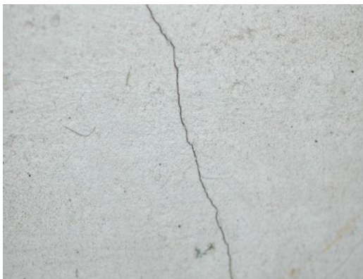
Σχ. 5.2.7. Ρωγή τσιμεντοκονιάματος επίχρισής με πραγματικό μάκρο - φακό (micro - Nikkor len)
