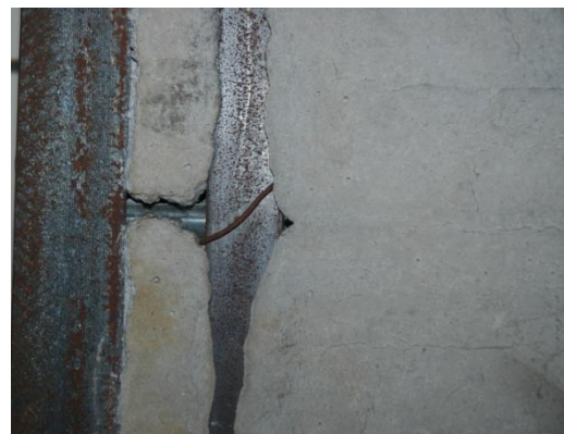
Σχ.5.2.2. Διάτρητη γαλβανιζέ λαμαρίνα πραγματικό μάκρο-φακό (micro-Nikkor len)
