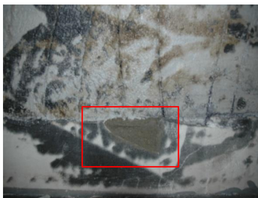
Σχ. 7.2.21. Καφετί τσιμεντοκονιάματος αποκατάστασης
