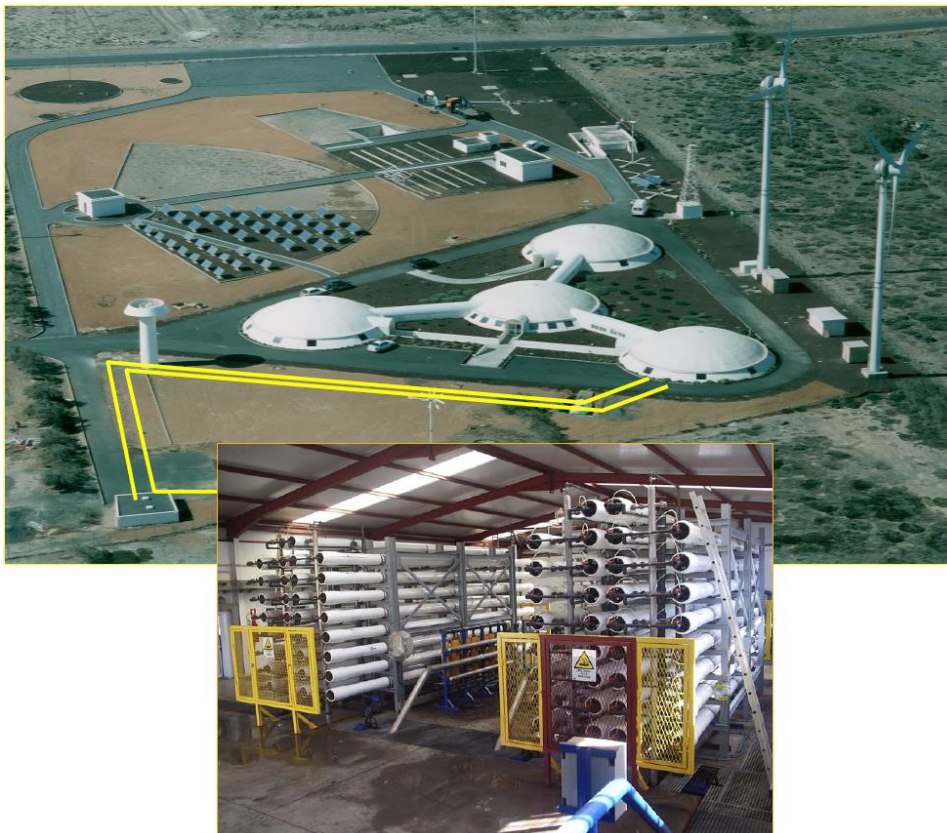
Εικόνα 3. Μονάδα αφαλάτωσης RO θαλασσινού νερού τροφοδοτούμενη από αιολικό πάρκο στην Γκραν Κανάρια των Κανάριων Νήσων [26].
