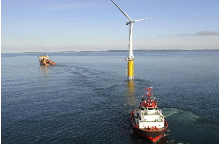
Εικόνα 1.23: Ρυμούλκηση της κατασκευής Hywind [41]
