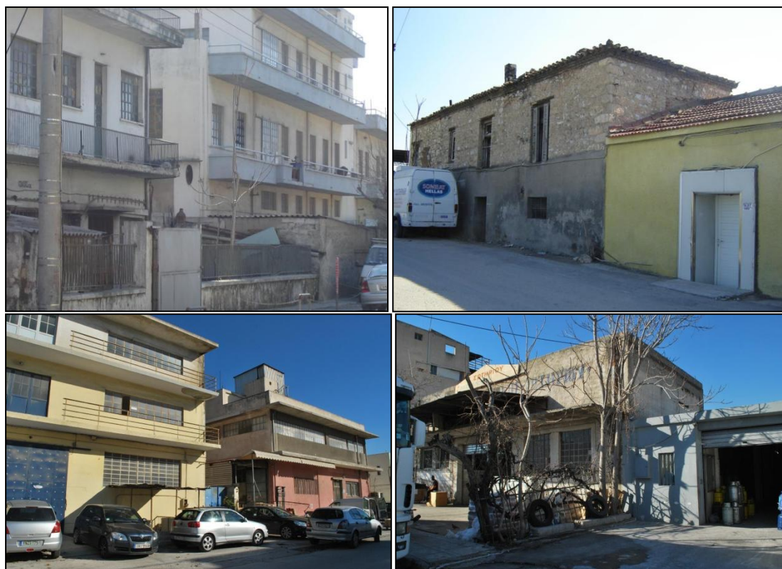
Εικόνα 65: Η γενικότερη εικόνα του κτηριακού δυναμικού της περιοχής. Χαμηλή δόμηση και κακή κατάσταση των κτηρίων (2011). Πηγή: Προσωπικό Αρχείο.
