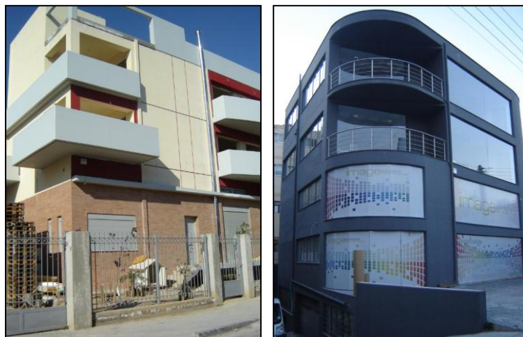
Εικόνα 64: Νεόδμητα κτήρια στην περιοχή μελέτης (2011). Τα νεόδμητα είναι ελάχιστα στην περιοχή, ενώ δεν εντοπίζονται συγκεντρωμένα σε κάποιο θύλακα, παρά διάσπαρτα, σε διάφορα σημεία. Πηγή: Προσωπικό Αρχείο.
