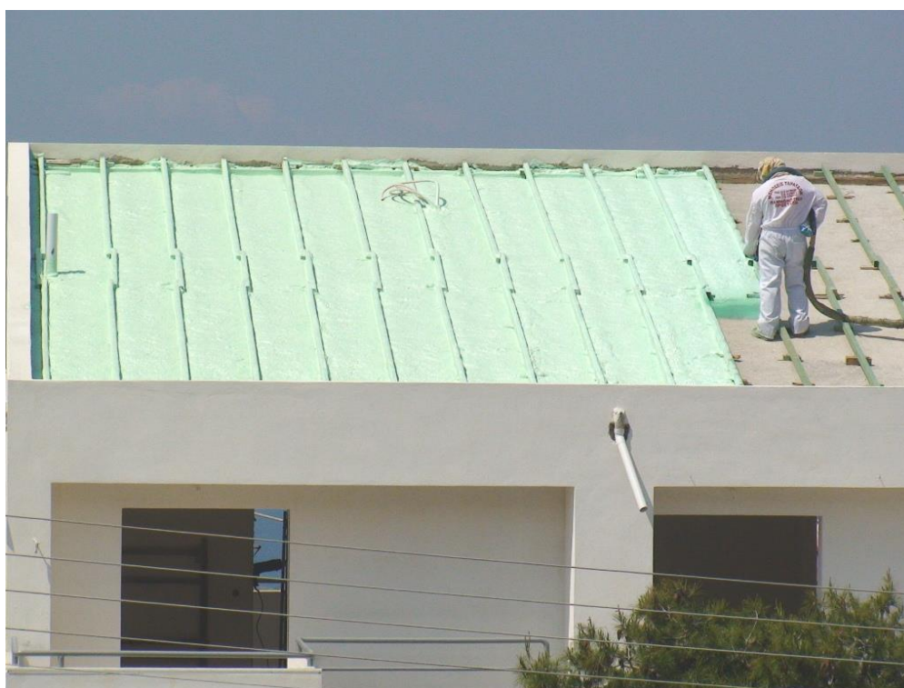
Σχήμα 2.1: Στέγη μονωμένη με αφρό πολυουρεθάνης.
