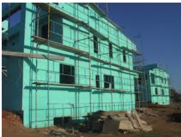
Σχήμα 2.6: Μόνωση κατοικιών με εξηλασμένη πολυστερίνη.
