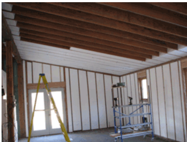
Σχήμα 2.9: Μόνωση κατοικίας με διογκωμένη πολυστερίνη.
