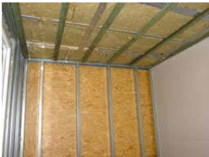
Σχήμα 2.4: Δωμάτιο μονωμένο με πετροβάμβακα.
