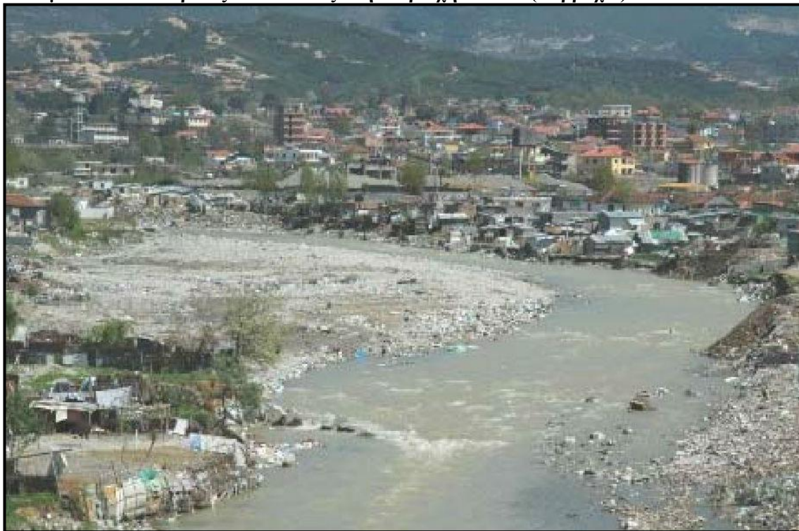
Έκθεμα 2.13: Αυθαίρετες κατασκευές στην περιοχή Kënetë (Δυρράχιο)
