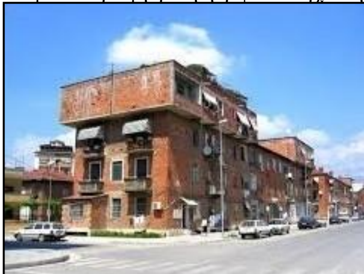
Έκθεμα 2.7: Παράνομη προσθήκη ορόφου σε υπάρχον κτήριο
