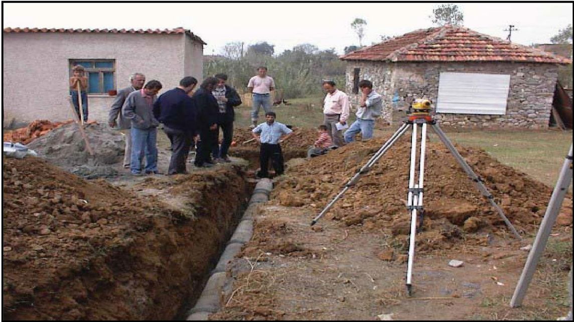
Έκθεμα 2.35: Κατασκευή αποχετευτικού δικτύου
