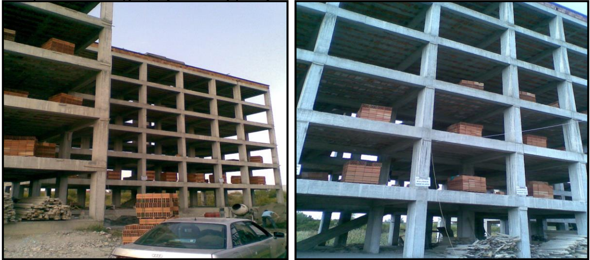
Έκθεμα 3.9: Φωτογραφίες από το εργοτάξιο
