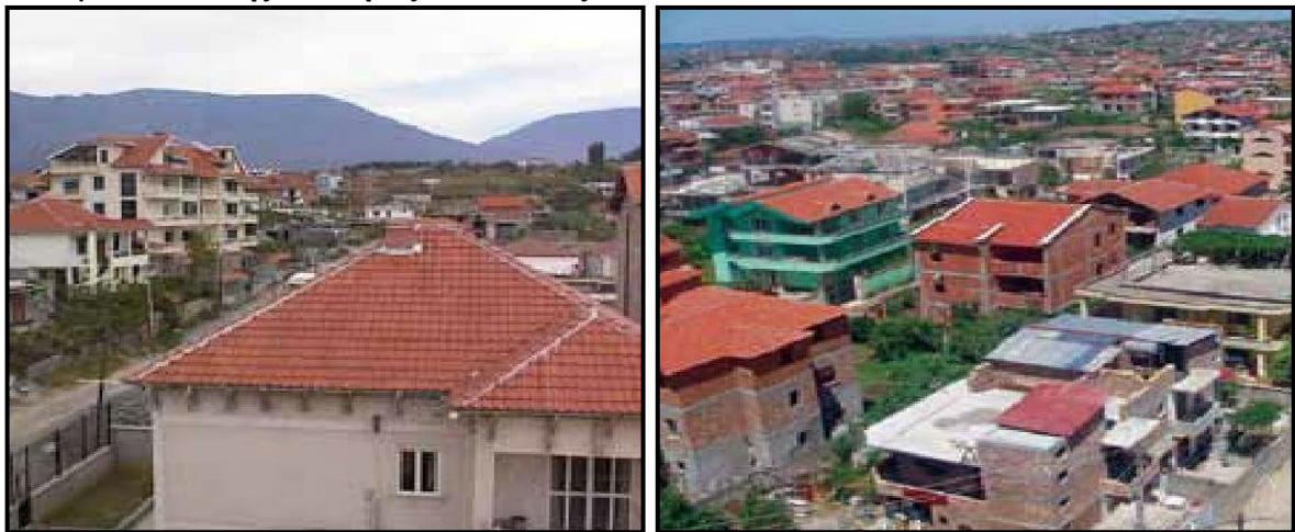
Έκθεμα 2.9: Καλής ποιότητας κατασκευές
