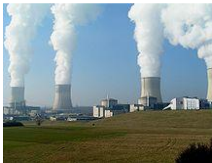
Εικόνα 36: Πυρηνικός σταθμός ενέργειας στο Κατενόμ της Γαλλίας. Μη ραδιενεργός ατμός εξέρχεται από τους ψυκτικούς πύργους. [41]
