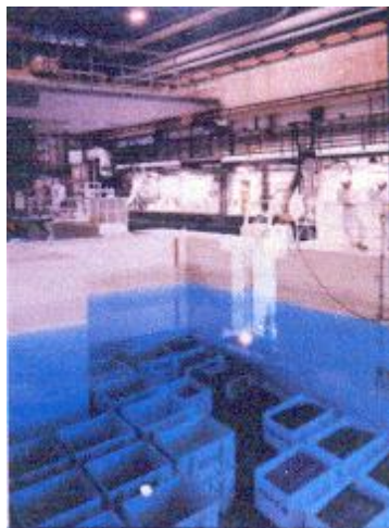
Εικόνα 21: Δεξαμενή εξαντλημένου καυσίμου: Ο ρόλος του νερού είναι διττός: εξασφαλίζει την απαραίτητη για τους εργαζομένους βιολογική θωράκιση και την ψύξη των ράβδων καυσίμου. [29]
