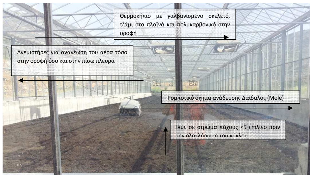
Εικόνα 4: Η μονάδα ηλιακής ξήρανσης του ΧΥΤΑ Χερσονήσου , δυναμικότητας 2000 τόνων/έτος.
