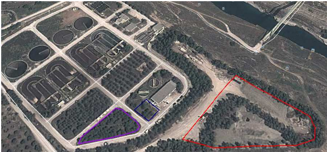
Εικόνα 1: Δορυφορική εικόνα της ΕΕΛ Κορίνθου-Λουτρακίου όπου διακρίνονται οι διαθέσιμες εκτάσεις εντός αυτής. Κόκκινη : 6500-7000 m 2 , Μωβ: 1.100 m 2 , Μπλέ : 350 m 2
