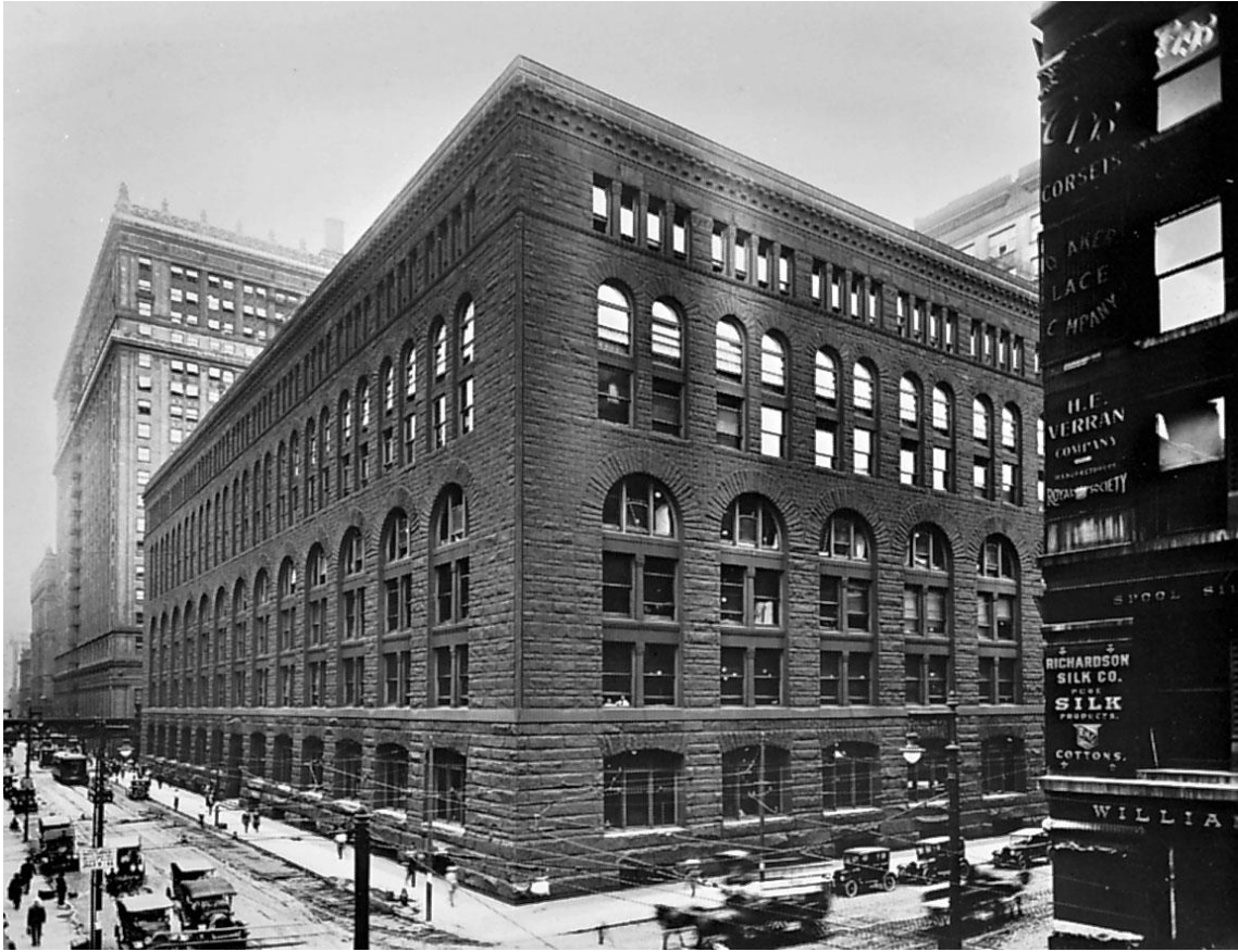
Εικόνα 2.8 : Marshall Field Warehouse, Chicago 1887
