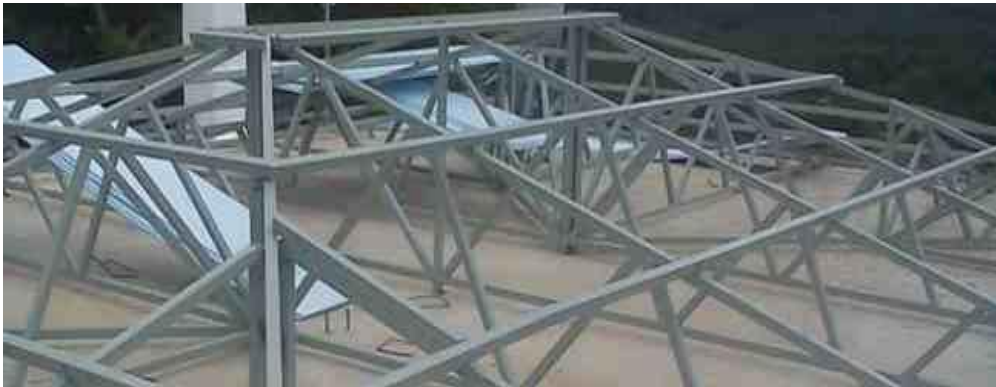
Σχήμα 1.16 : Χωροδικτύωμα με στοιχεία ψυχρής έλασης
