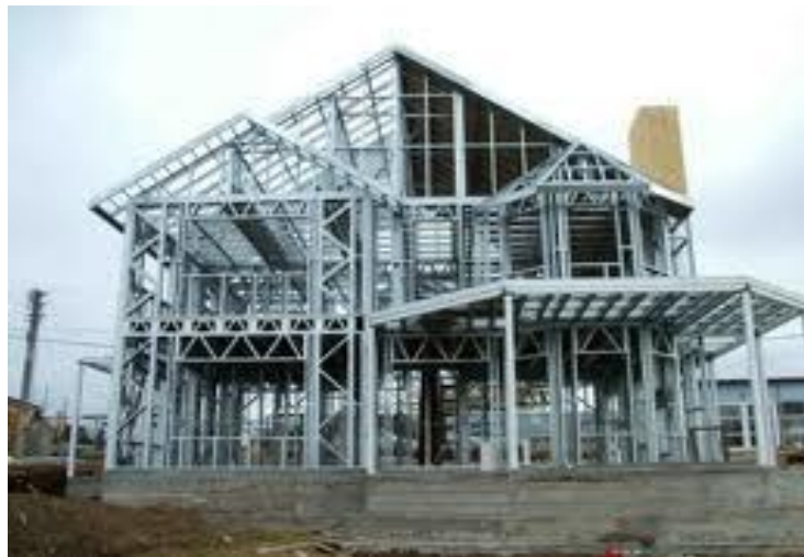
Σχήμα 1.4 : Μεταλλικός σκελετός κτιρίου
