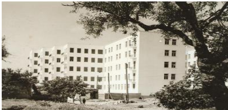
Εικόνα 5.11 Ανέγερση Μαιευτηρίου «Αλεξάνδρα», οδός Μιχαλακοπούλου –έτος 1952
