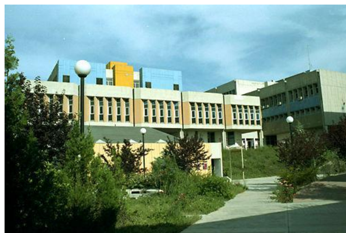
Εικ. 9.5: Δυτική όψη του μεσαίου τμήματος
