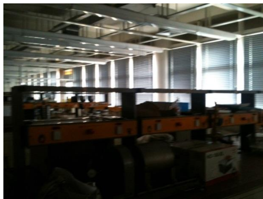
Εικ. 9.40: Ηλιοπροστατευτικά στόρια στο νότιο εργαστήριο της στάθμης 4 της πτέρυγας Δ
