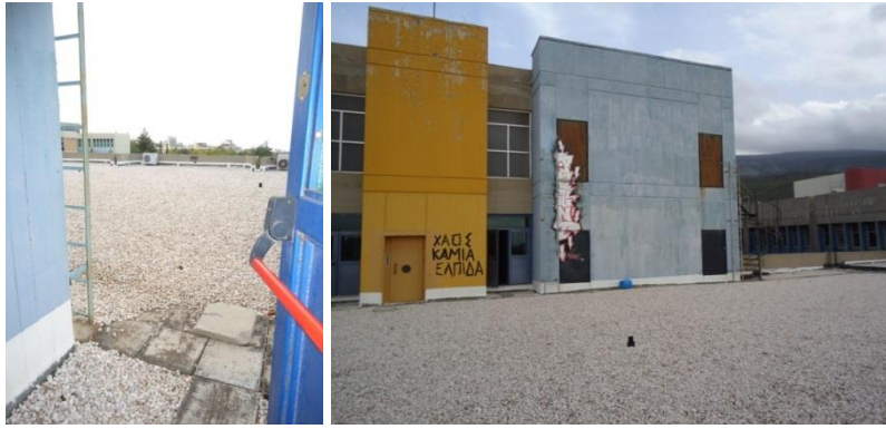
Εικ. 9.33: Διαμόρφωση του δόματος
