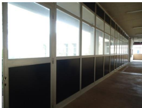
Εικ. 9.37: Υαλοστάσια κατά μήκος διαδρόμου της πτέρυγας Θ
