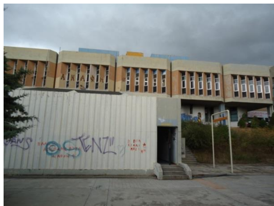
Εικ. 9.41: Βορειοδυτικά προσανατολισμένα παράθυρα στην δυτική όψη της πτέρυγας Α
