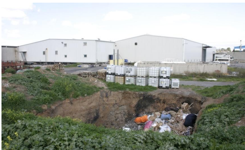
Εικόνα 2.6: Ανεξέλεγκτη διάθεση των στερεών αποβλήτων
