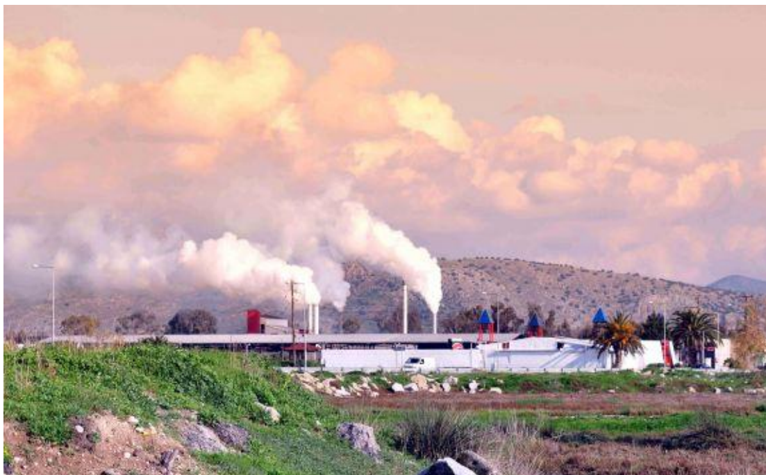
Εικόνα 2.7: Ατμοσφαιρική ρύπανση από βιομηχανίες
