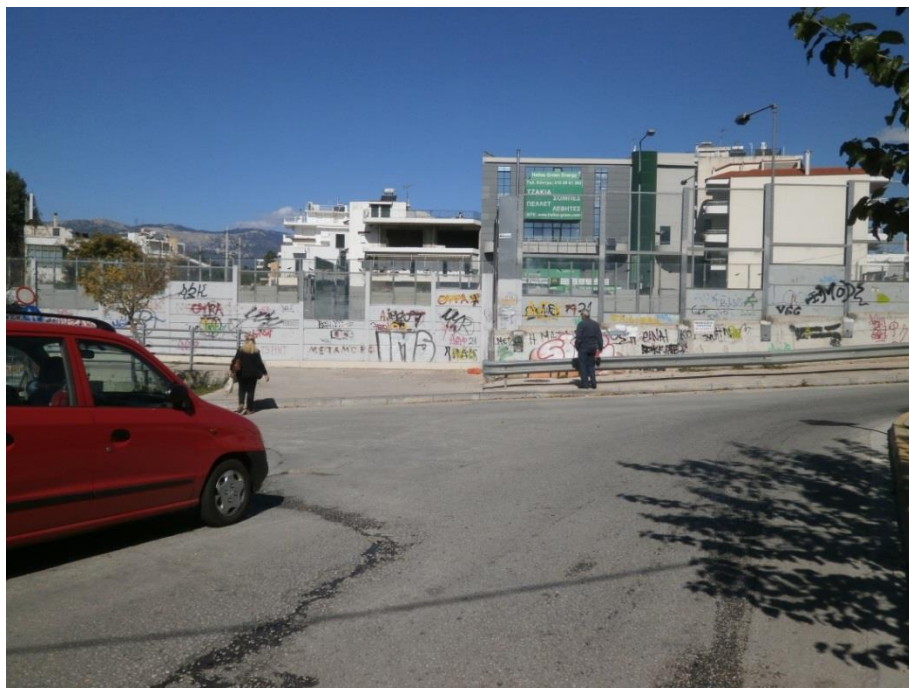
Εικόνα 5.2 : Οδός Πευκών και πεζοδρομημένη ράμπα.
