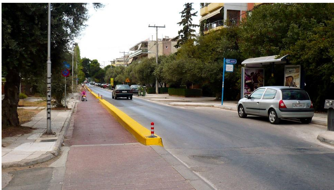
Εικόνα 3.8 : Τμήμα του ποδηλατοδρόμου στον Δήμο Χαλανδρίου. [INT. – 3]
