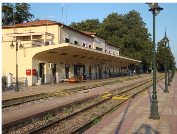
Εικόνα 11. Αποψη Σιδ. Σταθμού Λειανοκλαδίου. (Μάιος 2010) (Φωτογραφικό αρχείο – Τσαούση Β.)
