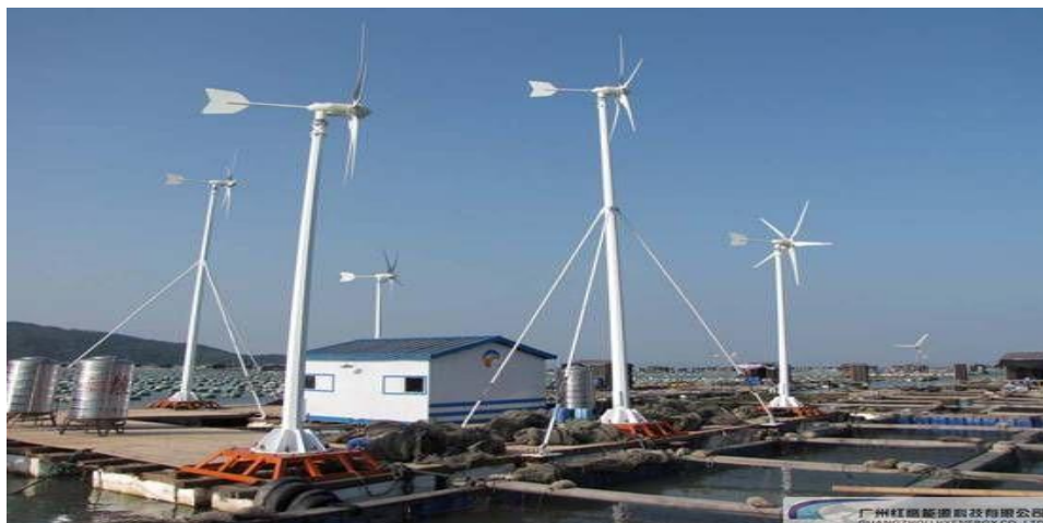
Εικόνα 3.18. Αιολικό και ηλιακό(υβριδικό) σύστημα παραγωγής ενέργειας για την αφαλάτωση νερού. [Πηγή: http://hyenergy.en.made-in-china.com/custom/EnxEJEmDQQbE/Projects-Gallery-1.html ]
