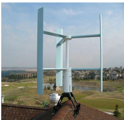
Εικόνα 3.21. Τρόποι στερέωσης οικιακών ανεμογεννητριών κατακόρυφου άξονα. Απ' ευθείας στερέωση (αριστερά), στερέωση σε βάση (δεξιά).
