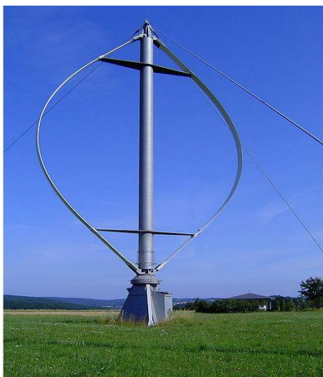
Εικόνα 3.10. Ανεμογεννήτριες κατακόρυφου άξονα, τύπου Darrieus (αριστερά) και τύπου Savonius (δεξιά). [Πηγές: http://de.wikipedia.org/wiki/Darrieus-Rotor , http://www.helixwind.com ]
