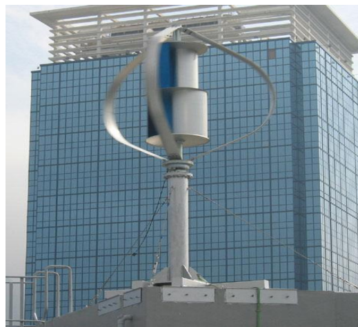
Εικόνα 3.21. Τρόποι στερέωσης οικιακών ανεμογεννητριών κατακόρυφου άξονα. Απ' ευθείας στερέωση (αριστερά), στερέωση σε βάση (δεξιά).
