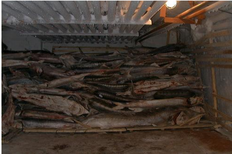
Εικόνα 5.9 Ψυκτικός θάλαμος αποθήκευσης κατεψυγμένων τόνων σε αμπάρι πλοίου (Πηγή: http://www.flickrriver.com )
