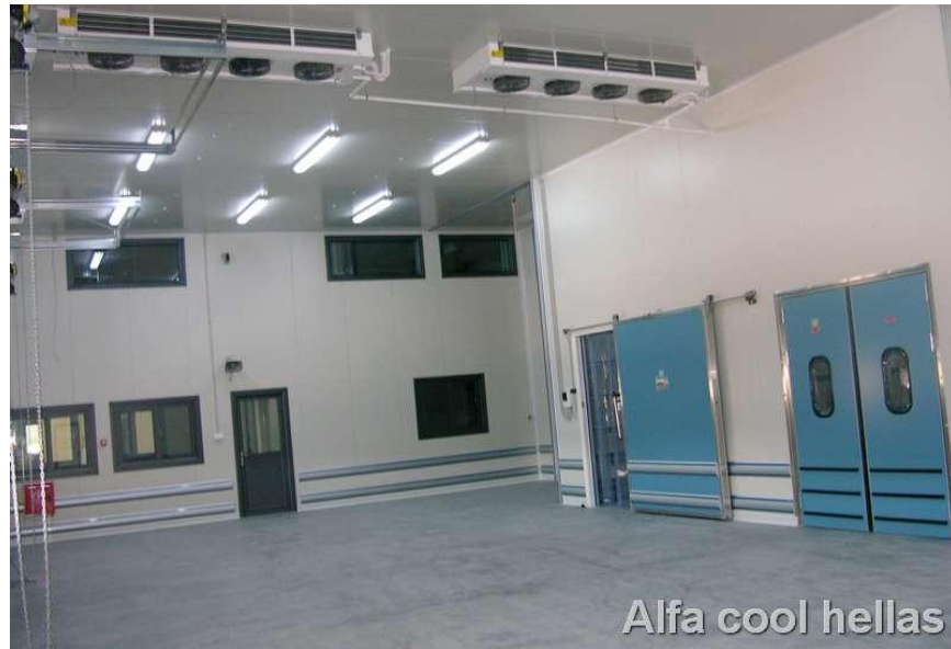
Εικόνα 4.10 Τοποθέτηση fan-coil φυγόκεντρης ροής στο κέντρο της οροφής του θαλάμου (Πηγή: http://www.alfacoolhellas.gr )
