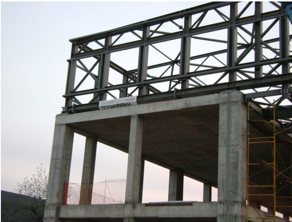
Εικ. 1.1: Μικτή καθ' ύψος κτιριακή κατασκευή
