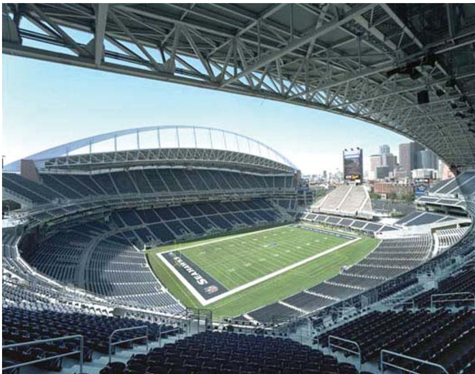
Εικ. 1.4: Γήπεδο με κερκίδες από ΟΣ και στέγαστρο από χάλυβα
