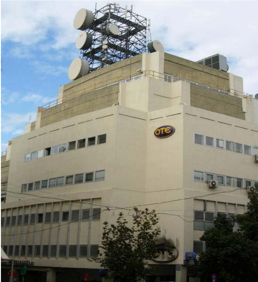
Εικ. 1.3: Τηλεπικοινωνιακός ιστός εδραζόμενος σε πολυώροφο κτίριο από ΟΣ
