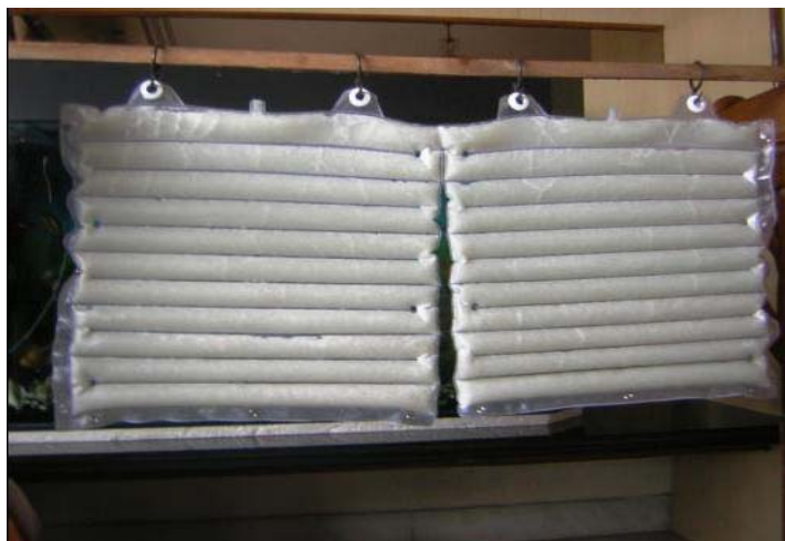
Σχήμα 3.29: Jacket μπαταρίας για εξωτερικό καταφύγιο τηλεπικοινωνιών .
