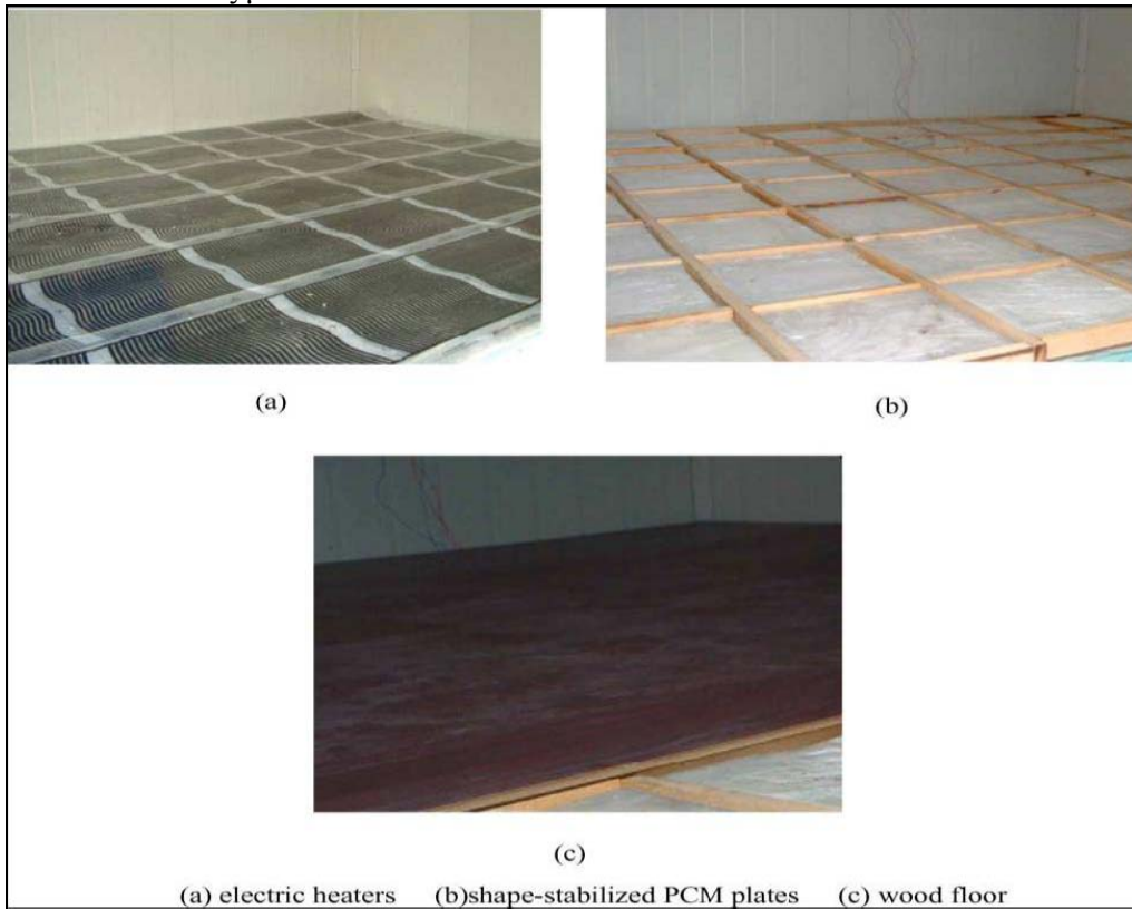
Σχήμα 4.22: Ηλεκτρικοί θερμαντήρες, shape-stabilized PCM πλάκες, ξύλινα δάπεδα
