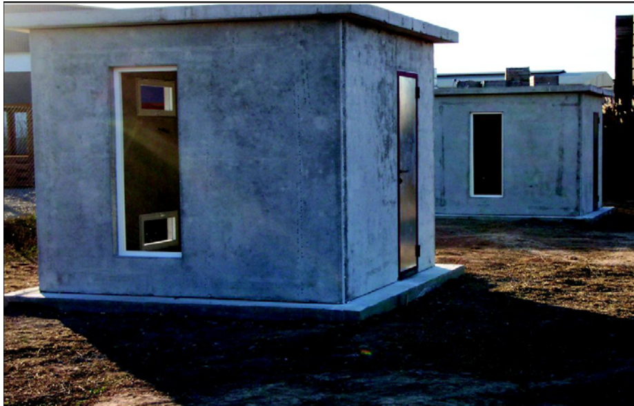
Σχήμα 4.11: Θάλαμοι με τοίχους από τσιμέντο και PCM.
