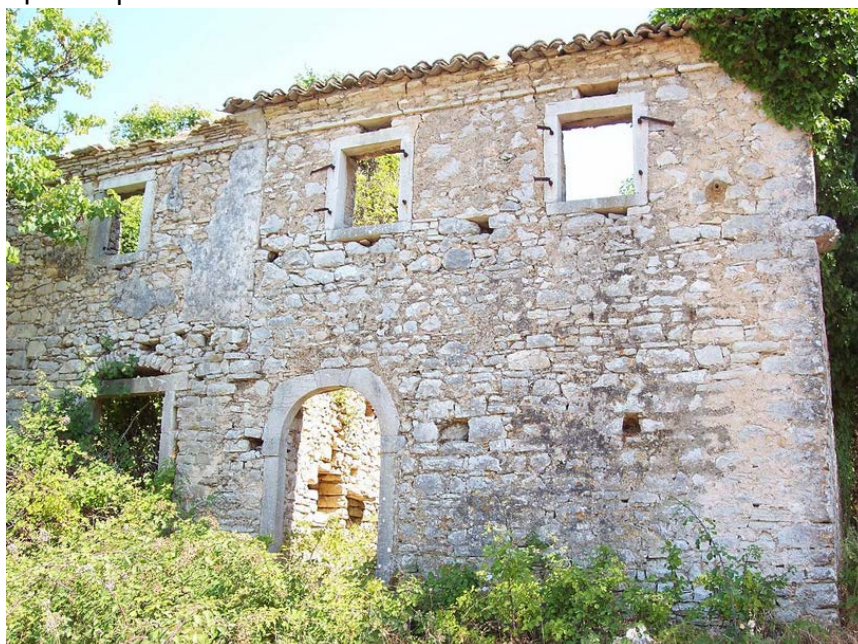
ΕΙΚΟΝΑ 1-4 ΠΑΡΑΔΕΙΓΜΑ ΑΡΓΟΛΙΘΟΔΟΜΗΣ
