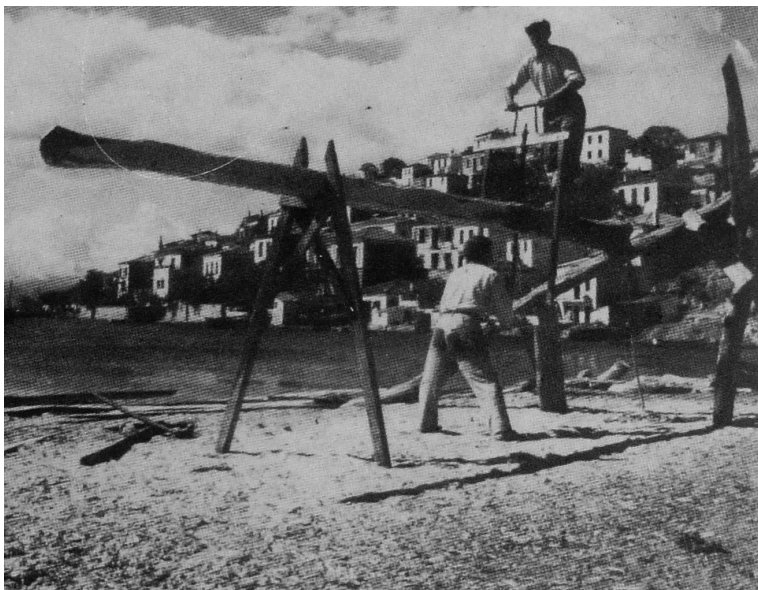
89. Σχίσσιμο ξύλων με κουρασotάρι, ή πικιά, στη Σκιάθο. Πηγή: π. Καλλιανός Κωνσταντίνος
