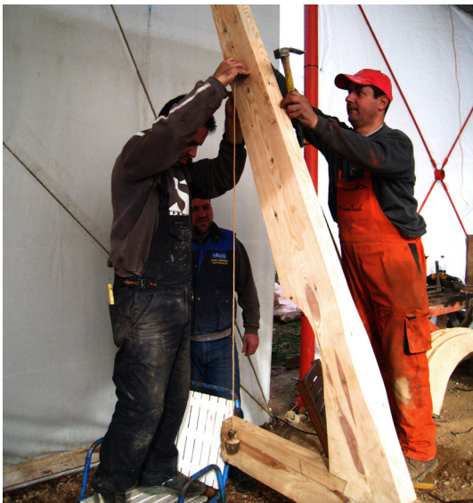
94. Έλεγχος της κατακορυφότητας του πρυνιού ποδοσταμάτος με το νήμα της στάθμης
