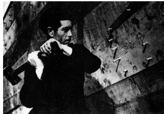
27. Κατακάρφωμα των καρφιών των μαδεριών του πετωμάτος, 1940. Πηγή: Ναυπηγική και πλοία (1995) σ. 78
