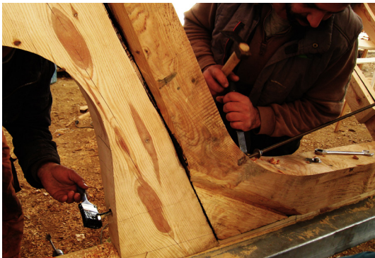
99. Αφού περαστεί η τζαβέτα, η τρύπα σφραγίζεται με καννάβι και πίσσα και σφίγγονται τα παξιμάδια
