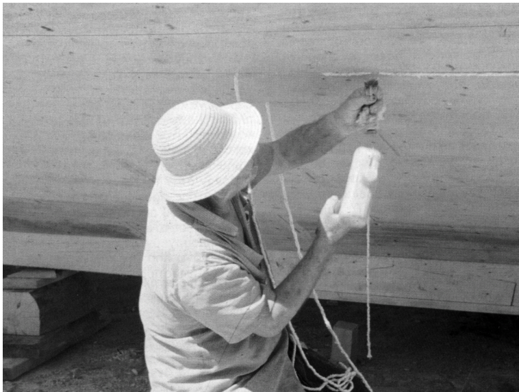
24. Καλαφάτης τοποθετεί το στουπί στους αρμούς του πετωμάτος ενός σκάφους, σε ναυπηγείο της Κοιλιάδας Αργολίδας, 1987. Πηγή: Δαμιανίδης (1998) σ. 212
