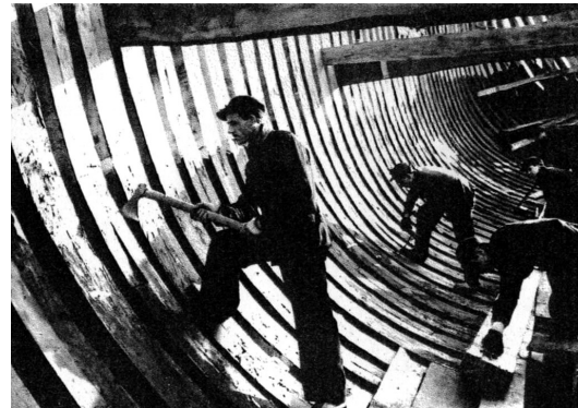
25. Συμπλεκόμενα με σκεπαρνιά από τους πελεκιτζήδες, 1940. Πηγή: Ναυπηγική και πλοία (1995) σ. 70
