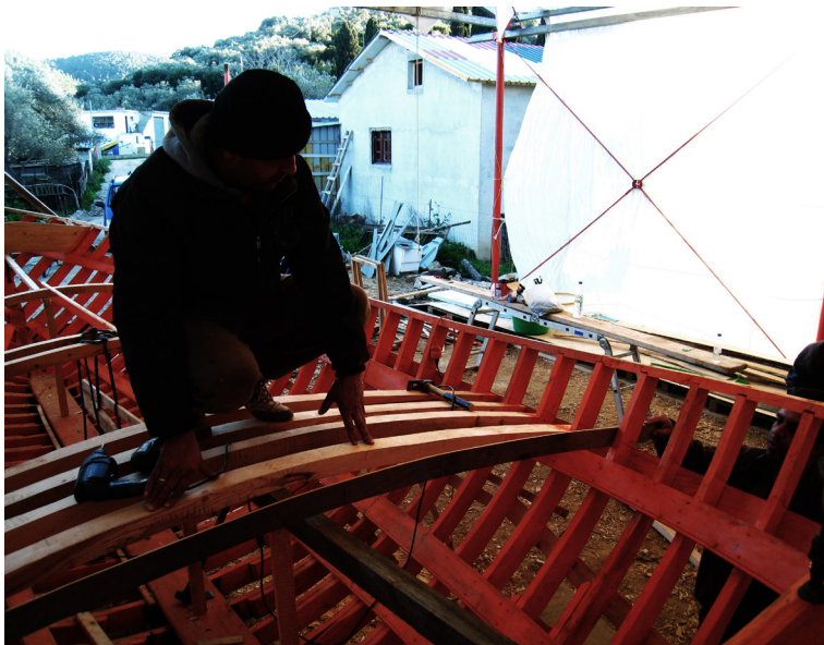
141. Διαμόρφωση του χναριού για κάθε καμάρι επί τόπου
