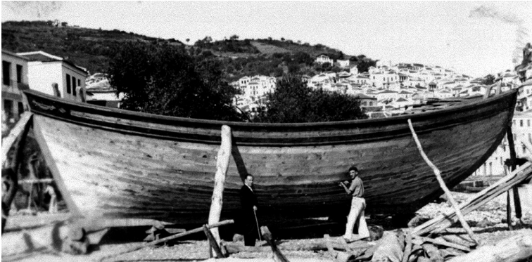
8. Ναυπηγούμενη trexanτήρα στο Ναυπηγείο της Χώρας της Σκοπέλου, μέσα 20ου αιώνα. Πηγή: Λαογραφικό Μουσείο Σκοπέλου
