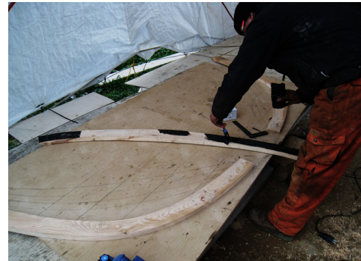
103. Οι επιφάνειες που αλληλοεπικαλύπτονται περνιούνται πίσω
