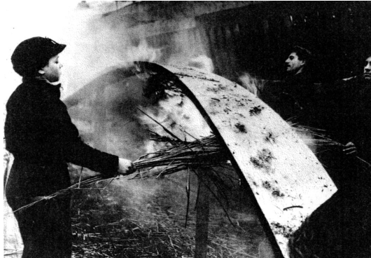
182. Στράβωμα μαδεριών με ζέσταμα πάνω από φλόγα, 1940. Πηγή: Ναυπηγική και πλοία (1995) σ. 70
