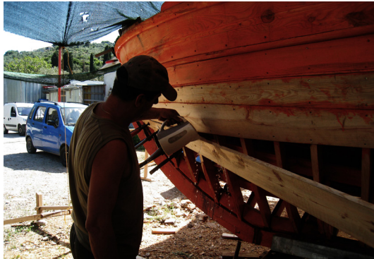
183. Στο καρνάγιο του Κωστή χρησιμοποιείται καυτό νερό για το ευκολότερο στράβωμα των μαδεριών
