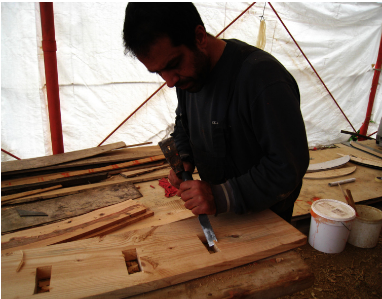
147. Διεύρυνση της κάτω πλευράς των οπών με το σκαρπέλο
