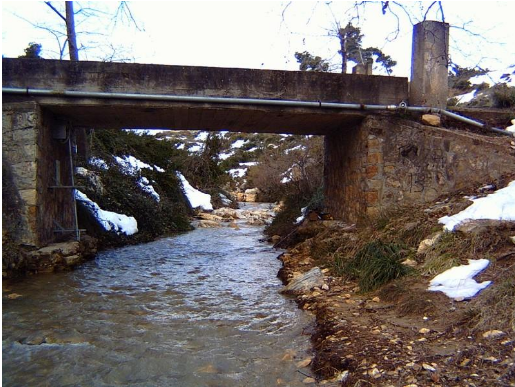
Εικόνα 4.8 Θέση υδρομέτρησης ( http://meteo.chi.civil.ntua.gr/el/basin.php )
