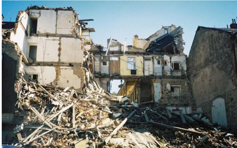
Εικόνα 2.5 Ζημιές λόγω της πλημμύρας στη περιοχή Karlin της Πράγας Τσεχικής Δημοκρατίας (Βικιπαίδεια)
