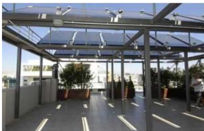
Σχήμα 1.5: Το πρώτο ενεργειακά αυτόνομο κτίριο στην Ελλάδα (Παλαιό Φάληρο), εξασφαλίζει οικονομία ενέργειας έως και 90% [9].
