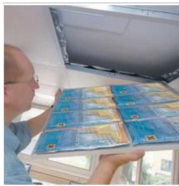
ΣΧΗΜΑ 9.3 Εφαρμογή ΥΑΦ σε σακουλάκια με αλουμινένιο περίβλημα. [6]
