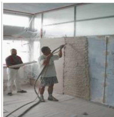
ΣΧΗΜΑ 9.4 Εφαρμογή επιχρίσματος με πρόσμιξη μικροκάψουλων ΥΑΦ [6]
