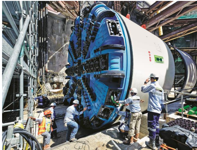
Εικόνα 2.2 Συναρμολόγηση μηχανήματος με ασπίδα Mixshield, διαμέτρου \varnothing 6,600 mm για το Μετρό της Σιγκαπούρης (Πηγή: Herrenknecht AG)
