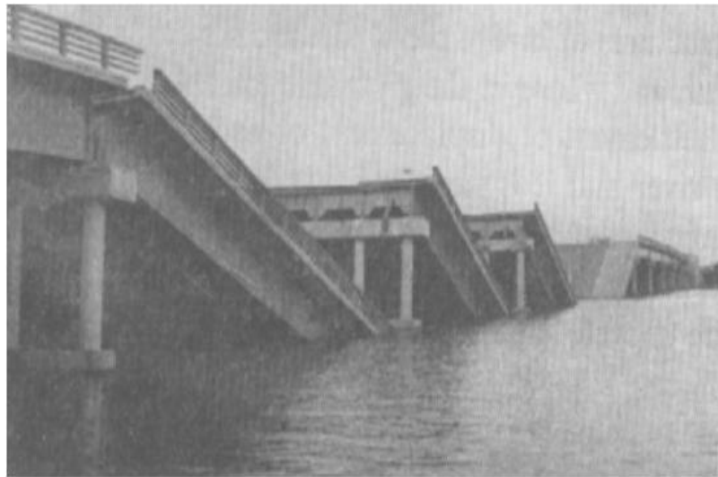
Εικόνα 2.1 : Πτώση αμφιρέιπων τμημάτων του φορέα της γέφυρας Showa-Hashi στο σεισμό της Niigata, Ιαπωνία, το 1964
