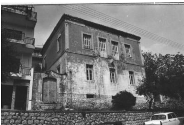
Εικόνα 6-35: διατηρητέο κτίριο επί της οδού Ησαΐα. πηγή: Υπουργείο Περιβάλλοντος και Κλιματικής Αλλαγής
