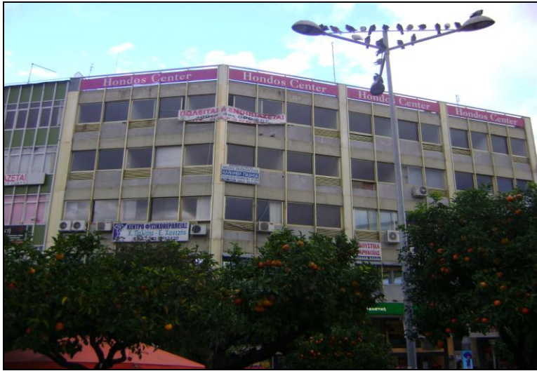
Εικόνα 6-46: κτίριο στο κέντρο της πόλης σε κατάσταση εγκατάλειψης και απουσίας συντήρησης που υποβαθμίζει το οικιστικό περιβάλλον της περιοχής μελέτης. πηγή: προσωπικό αρχείο
