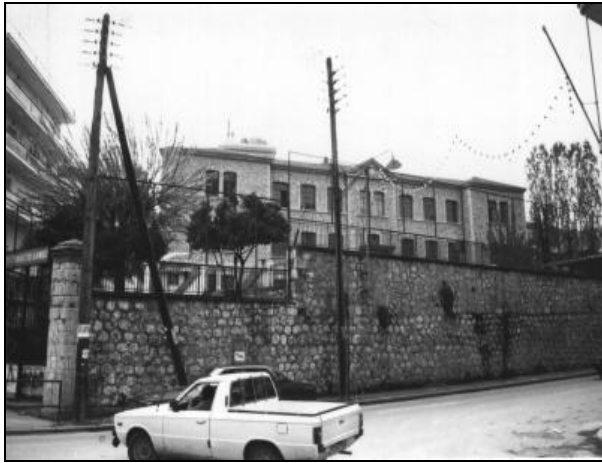
Εικόνα 6-39: διατηρητέο κτίριο επί της οδού Υψηλάντου. πηγή: Υπουργείο Περιβάλλοντος και Κλιματικής Αλλαγής
