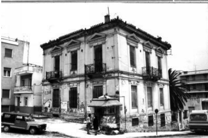
Εικόνα 6-29: διατηρητέο κτίριο επί της οδού Καραγιαννοπούλου πηγή: Υπουργείο Περιβάλλοντος και Κλιματικής Αλλαγής
