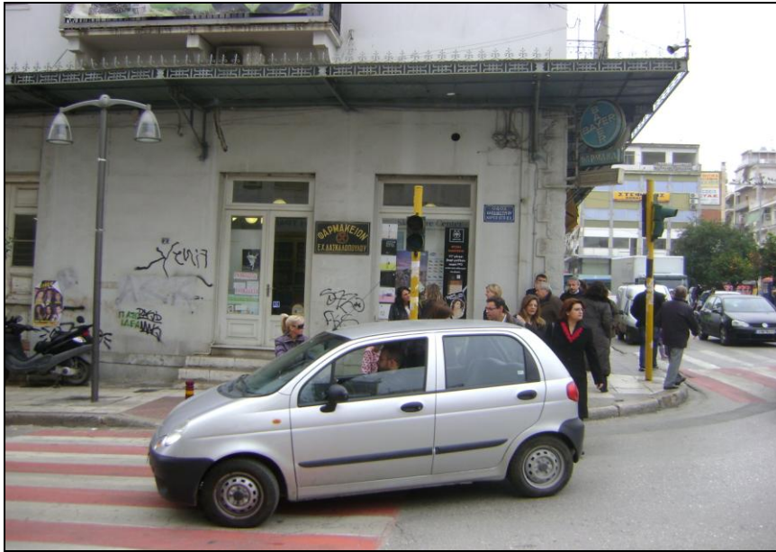
Εικόνα 6-49: κτίριο στο κέντρο της πόλης με έντονα σημάδια υποβάθμισης της αισθητικής του. πηγή: προσωπικό αρχείο
