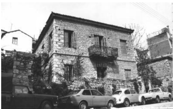
Εικόνα 6-36: διατηρητέο κτίριο επί της οδού Ησαΐα. πηγή: Υπουργείο Περιβάλλοντος και Κλιματικής Αλλαγής
