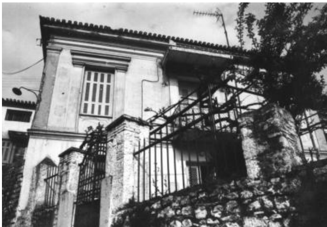
Εικόνα 6-30: διατηρητέο κτίριο επί της οδού Καραϊσκάκη πηγή: Υπουργείο Περιβάλλοντος και Κλιματικής Αλλαγής
