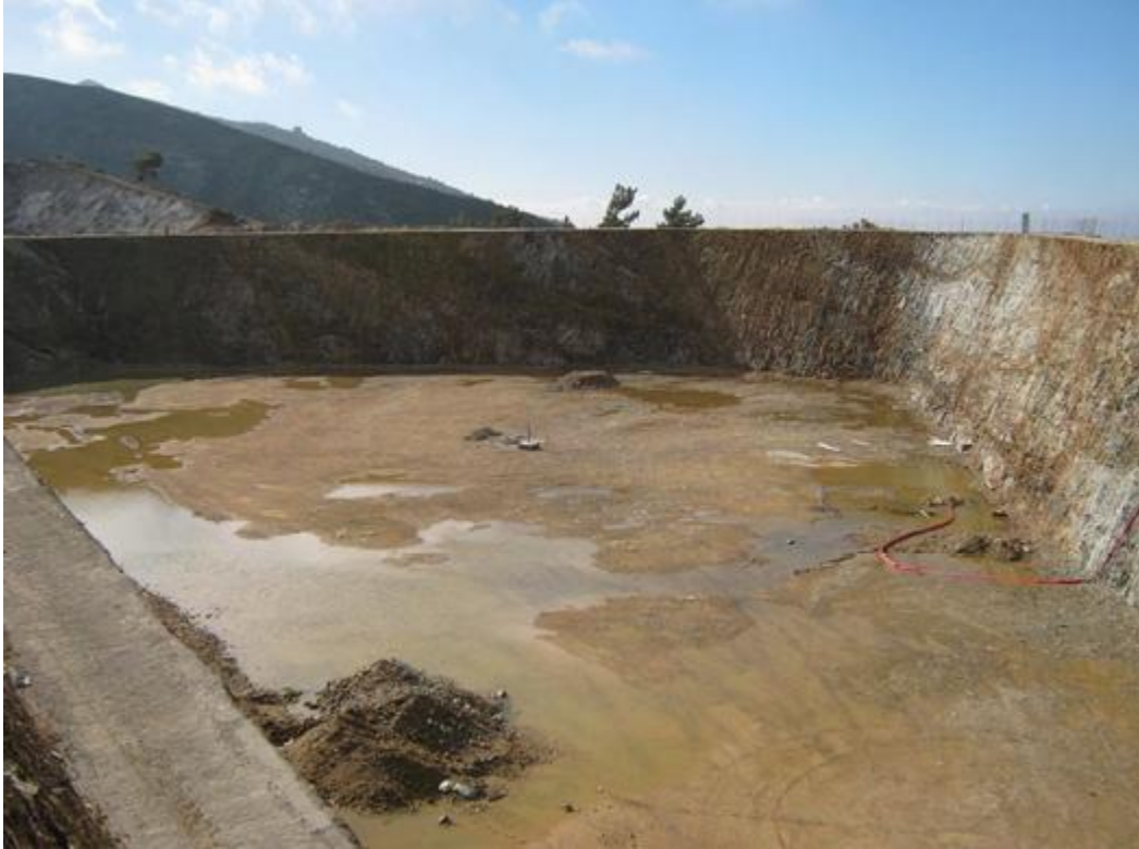
Εικόνα 5-2: Κατασκευή άνω Δεξαμενής
