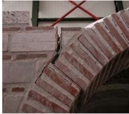
Σχήμα 2.14: Αποκόλληση σταυροθολίου στη νότια και βόρεια όψη
