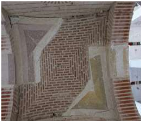
Σχήμα 2.15: Ρωγμές στο σταυροθόλιο εσωτερικά και εξωτερικά
