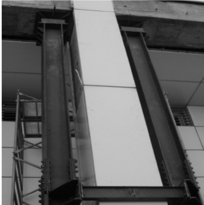
Σχήμα 5.6 Εφεδρική ενίσχυση στη θέση εγκατάστασης των σεισμικών εφεδράνων.
