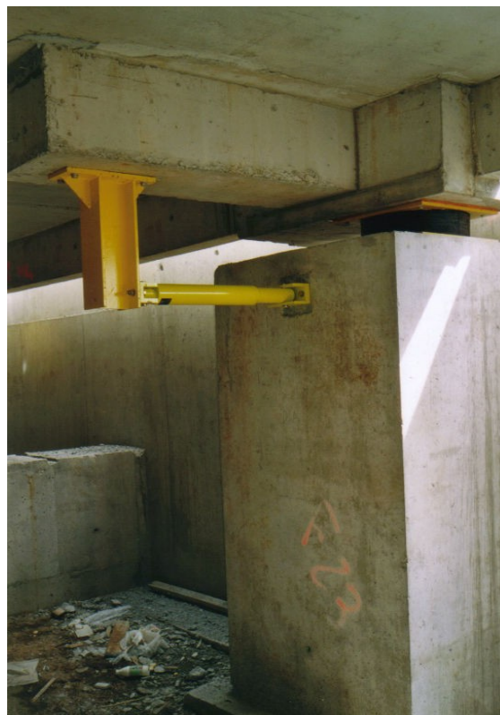
Σχήμα 5.9 Εγκατάσταση συστήματος εφεδράνου αποσβεστήρα.
