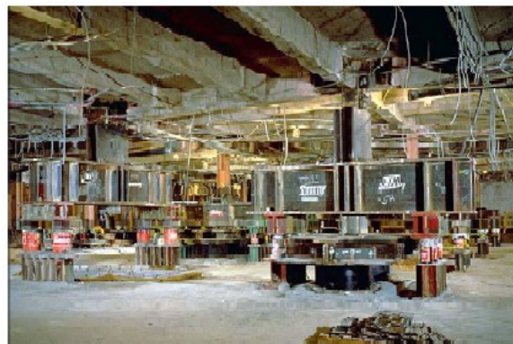
Σχήμα 2.11 Διάταξη εφεδράνων στο επίπεδο της θεμελίωσης.
