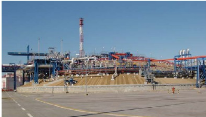
Σχήμα 2.12 Έργο δεξαμενής φυσικού αερίου.
