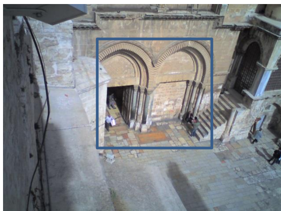
Εικόνα 19: Νότια όψη της πρόσοψης του Ιερού Ναού της Αναστάσεως. Ημερομηνία: 27.1.2011, Ώρα:12.37, Θερμοκρασία: 22°C
