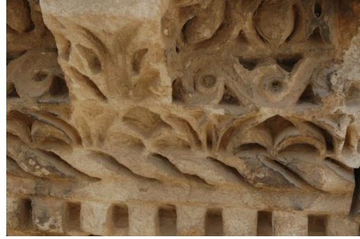
Εικόνα 3.9: Περιοχές μαύρης και καστανής χροιάς σε τμήματα του γείσου που προστατεύονται από τη βροχή
