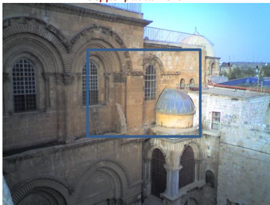
Εικόνα 13: Νότια όψη της πρόσοψης του Ιερού Ναού της Αναστάσεως. Ημερομηνία: 27.1.2011, Ώρα:16.49, Θερμοκρασία: 18°C
