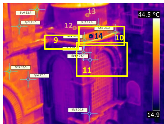
Θερμογράφημα 14: Θερμογράφημα που αντιστοιχεί στην περιοχή εντός του πλαισίου της Εικόνας 15
