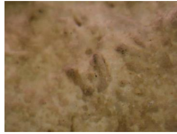
Εικόνα 7: Περιοχή αποπλυμένης επιφάνειας
