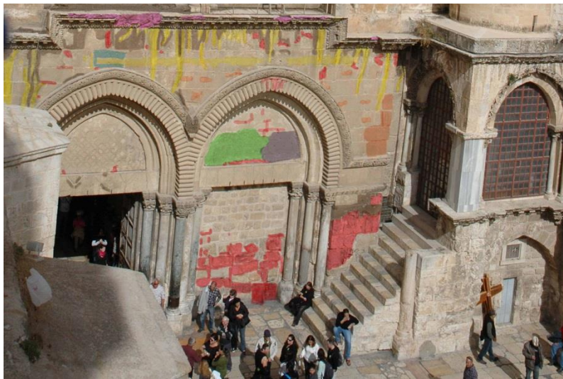
Εικόνα 4.5: Χαρτογράφηση της φθοράς στο κάτω τμήμα της νότιας όψης του Ιερού Ναού της Αναστάσεως
