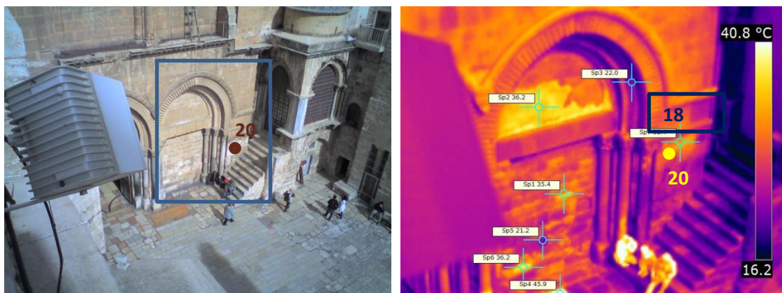
Εικόνα 28: Νότια όψη της πρόσοψης του Ιερού Ναού της Αναστάσεως. Ημερομηνία: 27.1.2011, Ώρα:12.37, Θερμοκρασία: 22°C
