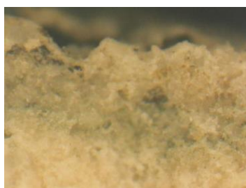
Εικόνα 22: Μεγέθυνση X120. Διεπιφάνεια διαβρωμένης και υγιούς περιοχής
