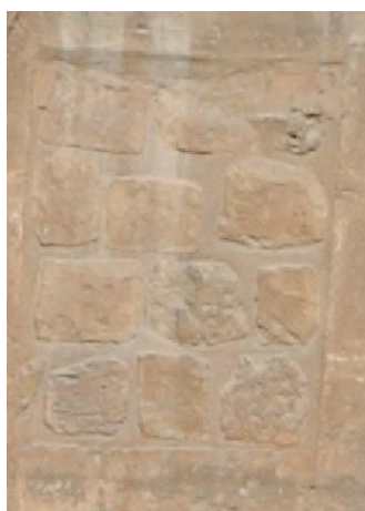
Εικόνα 3.6: Προσθήκη λίθων στην τοιχοποιία της νότιας όψης
