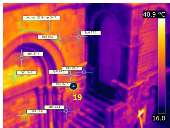
Θερμογράφημα 27: Θερμογράφημα που αντιστοιχεί στην περιοχή εντός του πλαισίου της Εικόνας 27
