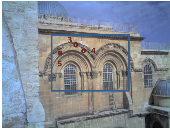
Εικόνα 3: Νότια όψη της πρόσοψης του Ιερού Ναού της Αναστάσεως. Ημερομηνία 27.1.2011, Ώρα:12.39, Θερμοκρασία: 22°C
