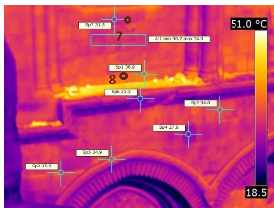
Θερμογράφημα 7: Θερμογράφημα που αντιστοιχεί στην περιοχή εντός του πλαισίου της Εικόνας 7
