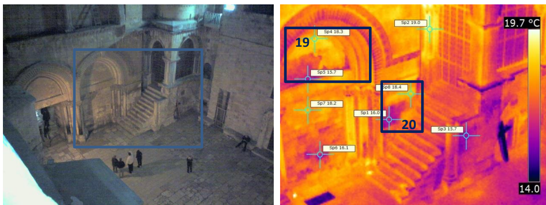
Εικόνα 29: Νότια όψη της πρόσοψης του Ιερού Ναού της Αναστάσεως. Ημερομηνία: 27.1.2011, Ώρα:18.42, Θερμοκρασία: 17°C
