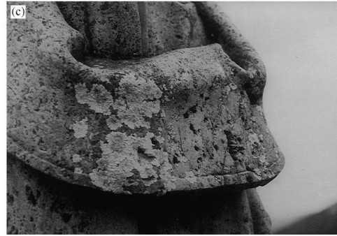
Εικόνα 1.7: Βελονοειδής διάβρωση εξαιτίας της ανάπτυξης λειχήνων σε δολομιτικά εγκλείσματα λίθου (41)
