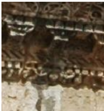
Εικόνα 3.2: Φαιόμαυρες περιοχές σε επιφάνεια που προστατεύεται από το βρόχινο νερό
