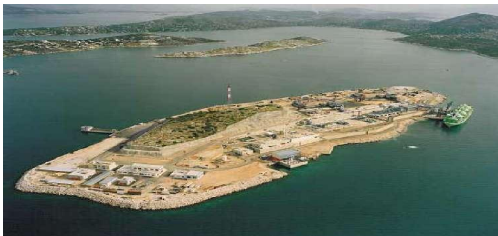
Εικόνα 2.3 Σταθμός Ρεθυθούσας (ΔΕΣΦΑ, Μελέτη Ανάπτυξης ΕΣΦΑ 2013-2022, 2012)
