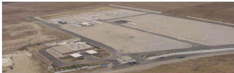
Εικόνα 2.2 Σταθμός Κήποι Έβρου (ΔΕΣΦΑ, Μελέτη Ανάπτυξης ΕΣΦΑ 2013-2022, 2012)
