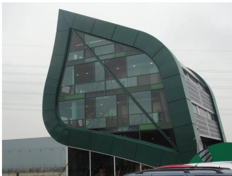
Εικόνα 68: Κτίριο γραφείων επιτροπής Ανανεώσιμων Πηγών Ενέργειας στην Ολλανδία, το οποίο φέρει σύστημα κλιματισμού με ενσωματωμένα ΥΑΦ [72]
