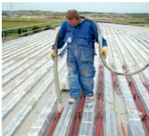
Εικόνα 61: Έκχυση τσιμέντου με προσμίξεις ΥΑΦ στην οροφή του κτιρίου WIL0, στην Ολλανδία [72]
