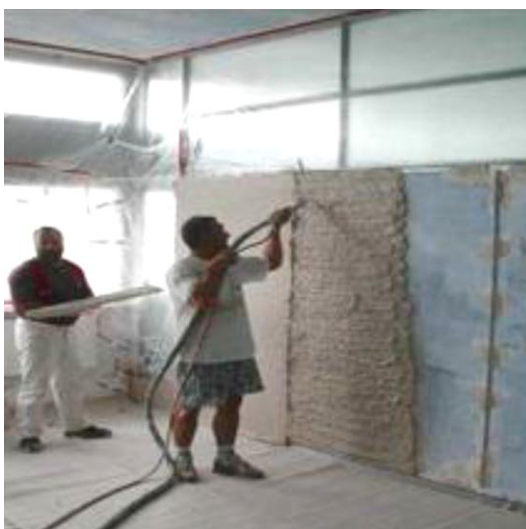
Εικόνα 53: Εφαρμογή επιχρίσματος με πρόσμιξη μικροκάψουλων ΥΑΦ σε γυψοσανίδα [72]
