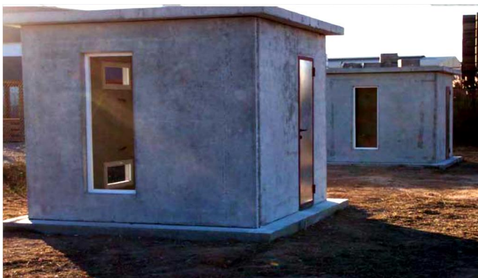
Εικόνα 73: Πειραματικοί οικίσκοι από οπλισμένο σκυρόδεμα με 5% ΥΑΦ, κατασκευασμένοι από το πανεπιστήμιο της Lleida [104]
