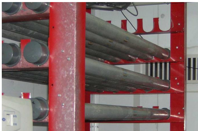
Εικόνα 37: Συσκευασίες Υλικών Αλλαγής Φάσης που χρησιμοποιούνται σε τηλεπικοινωνιακά κουβούκλια [51]
