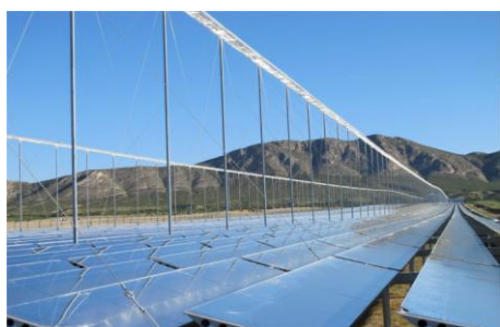
Εικόνα 9 Ηλιοθερμικός σταθμός παραγωγής τεχνολογίας Fresnel
