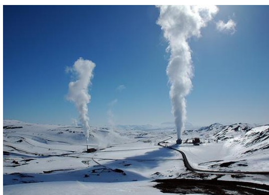
Εικόνα 21 Αξιοποίηση ενέργειας γεωθερμίας
