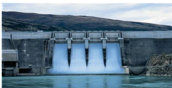
Εικόνα 16 Υδροηλεκτρικός σταθμός μικρής κλίμακας
