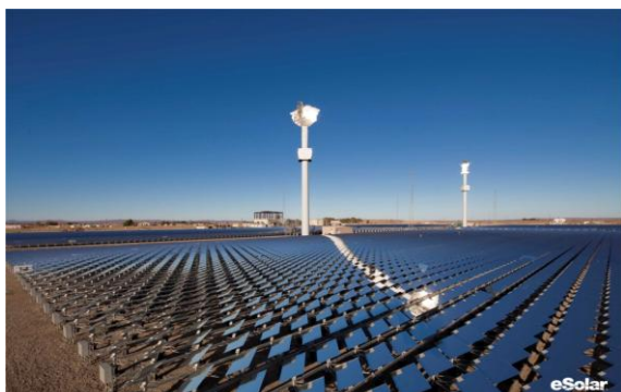
Εικόνα 7 Ηλιοθερμικός σταθμός τεχνολογίας Κεντρικού Δέκτη
