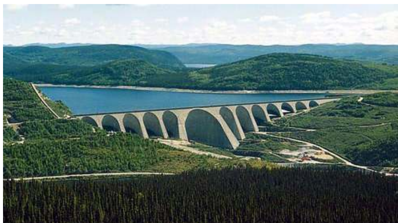
Εικόνα 1.4. Αντιρηδωτό φράγμα βαρύτητας στον Καναδά (Daniel - Johnson dam)
