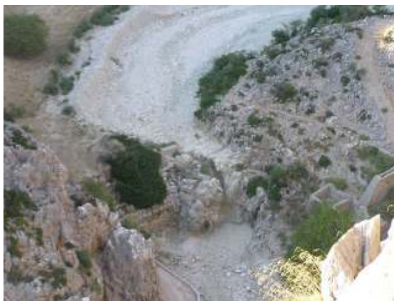
Εικόνα 1.2. Φράγμα Αρχαίας Αλυζίας (Πηγή: Ζαρκαδούλας, 2005)
