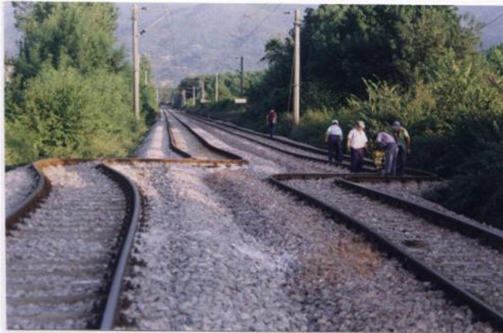
Εικόνα 5.36. Παραμόρφωση της σιδηροδρομικής γραμμής με το σεισμό του 1999, νοτιοανατολικά της πόλης Izmit
