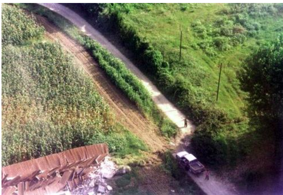
Εικόνα 5.34. Μετατόπιση του δρόμου και ζημιές σε σπίτια στις θέσεις ιέλευσης του σεισμικού ρήγματος του 1999
