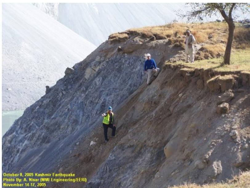
Εικόνα 5.57. Άποψη των σεισμικών διαρρήξεων που συνδέονται με το σεισμό του 2005 και το ρήγμα Balakot του βορειοδυτικού Pakistan
