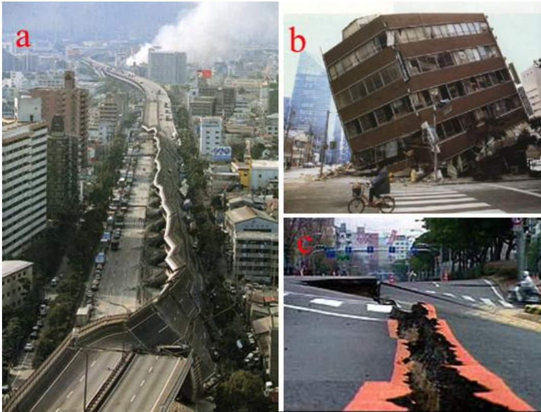
Εικόνα 5.33. Καταστροφές σε αυτοκινητόδρομους (a,c) και σε κτίρια (b) με το σεισμό του Kobe.
