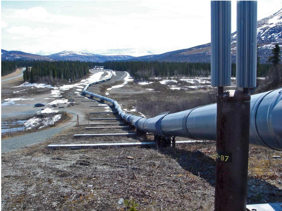
Εικόνα 5.38. Αντισεισμική κατασκευή αγωγού φυσικού αερίου στη περιοχή του ρήγματος Denali
