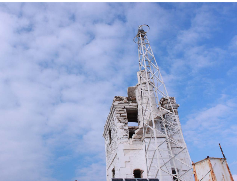
εικ. 66 | Εγκατάσταση μεταλλικής κατασκευής, Φάρος Γαυρίου, Άνδρος
