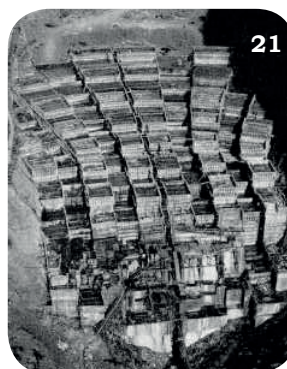
σκυροδέτηση με καλούπια
