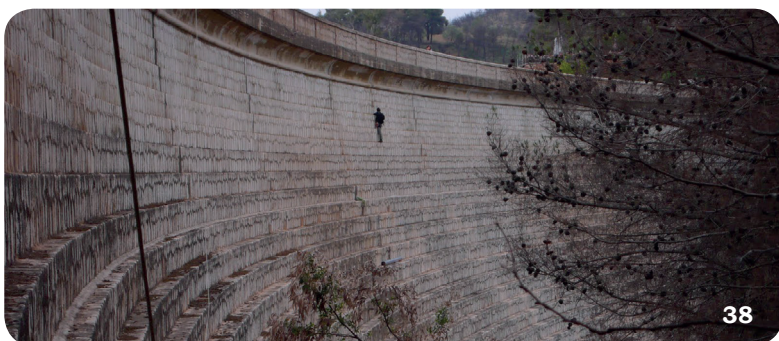
εικ. 38: Η κατάντη παρειά επενδυμένη με πεντελικό μάρμαρο
