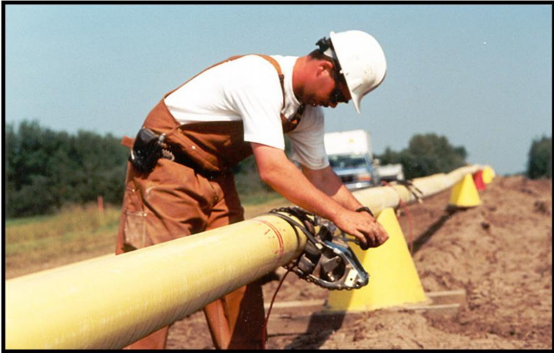
Εικόνα 3.3 : Έλεγχος γραμμής σωλήνων (pipeline), με τη μέθοδο της ραδιογραφίας.
