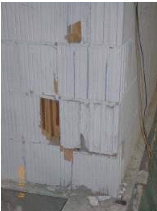
Εικόνα 5: Σπάσιμο οπτόπλινθων
