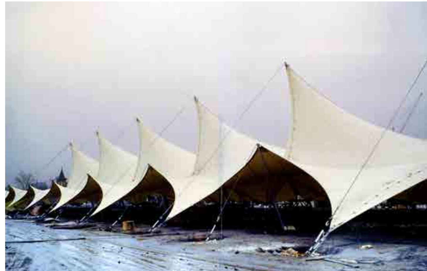
Η «κυματιστή οροφή» με τις οξυκόρυφες διαμορφώσεις και τα δεσίματα με σχοινί, Διεθνής έκθεση Κήπου στο Αμβούργο, 1963.
