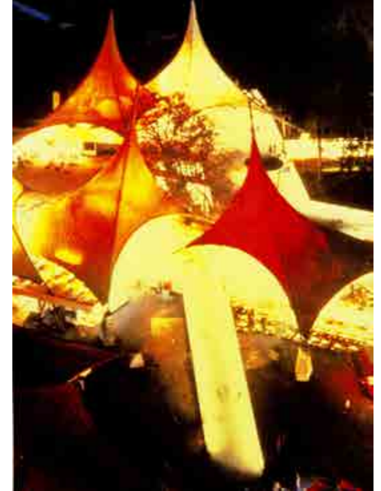
Ομοσπονδιακή έκθεση στη Λωζάνη, 1964. Οι οξυκόρυφες τέντες ύψους 24m στέγαζαν το ημιυπαίθριο εστιατόριο της έκθεσης. Η μεγάλη έκταση της επιφάνειας και η έντονη καμπυλότητα -σημάδι ισχυρής προέντασης, ξεπερνούσαν τις μηχανικές δυνατότητες των τότε συνθετικών υφασμάτων. Η ενίσχυση αυτών ήταν επιβεβλημένη. [αρχιτέκτονες: Marc Saughey και Manfred Shierle, σύμβουλος διαστασιολόγησης και κατασκευής: Frei Otto και συνεργάτες]
