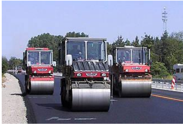
Εικόνα 4 Ασφαλτόστρωση με υλικό που εμπεριέχει σκωρία για μείωση θορύβου
