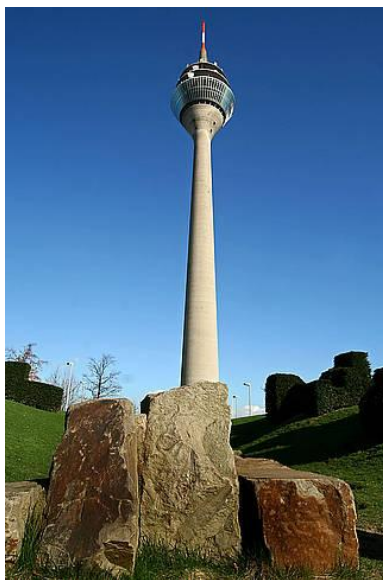
Εικόνα 5 Ο πύργος τηλεπικοινωνιών του Ντίσελντορφ με χρήση σκωριοτσιμέντου
