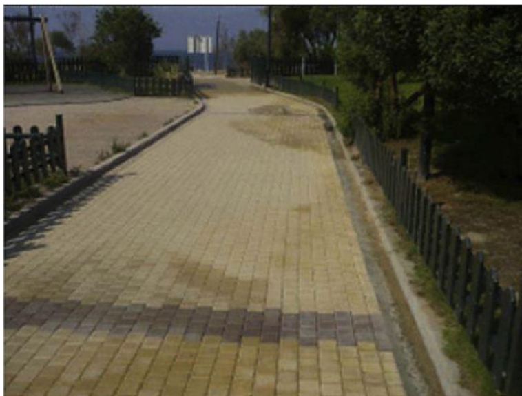
Εικόνα 12 Κυβόλιθοι με ψυχρά υλικά σε πάρκο στη περιοχή του Φλοίσβου
