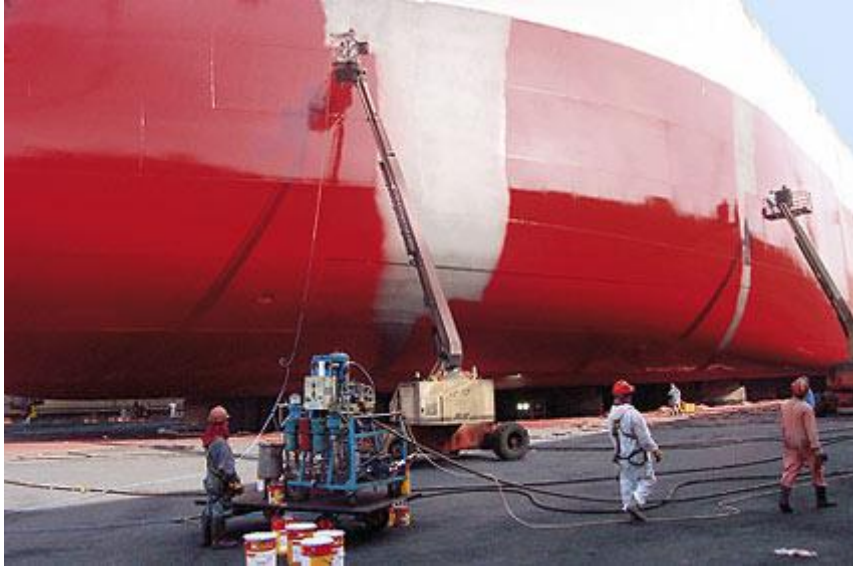
Σχ.6.4: εφαρμογή χρώματος με spray
