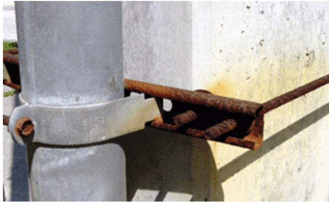
Σχ. 2.11: Διάβρωση λόγω επαφής διαφορετικών μετάλλων
