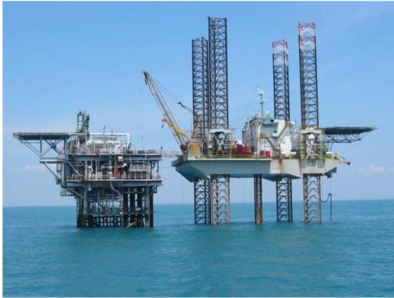
Σχ.6.5: Πλωτή κατασκευή jack up
